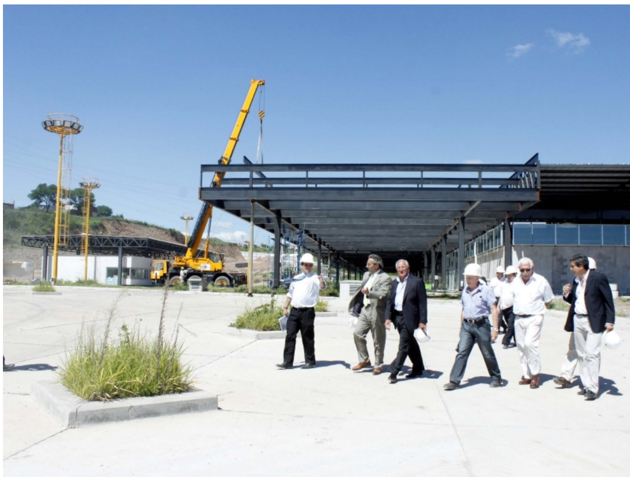
Fellner recorriendo los accesos de la nueva terminal.
